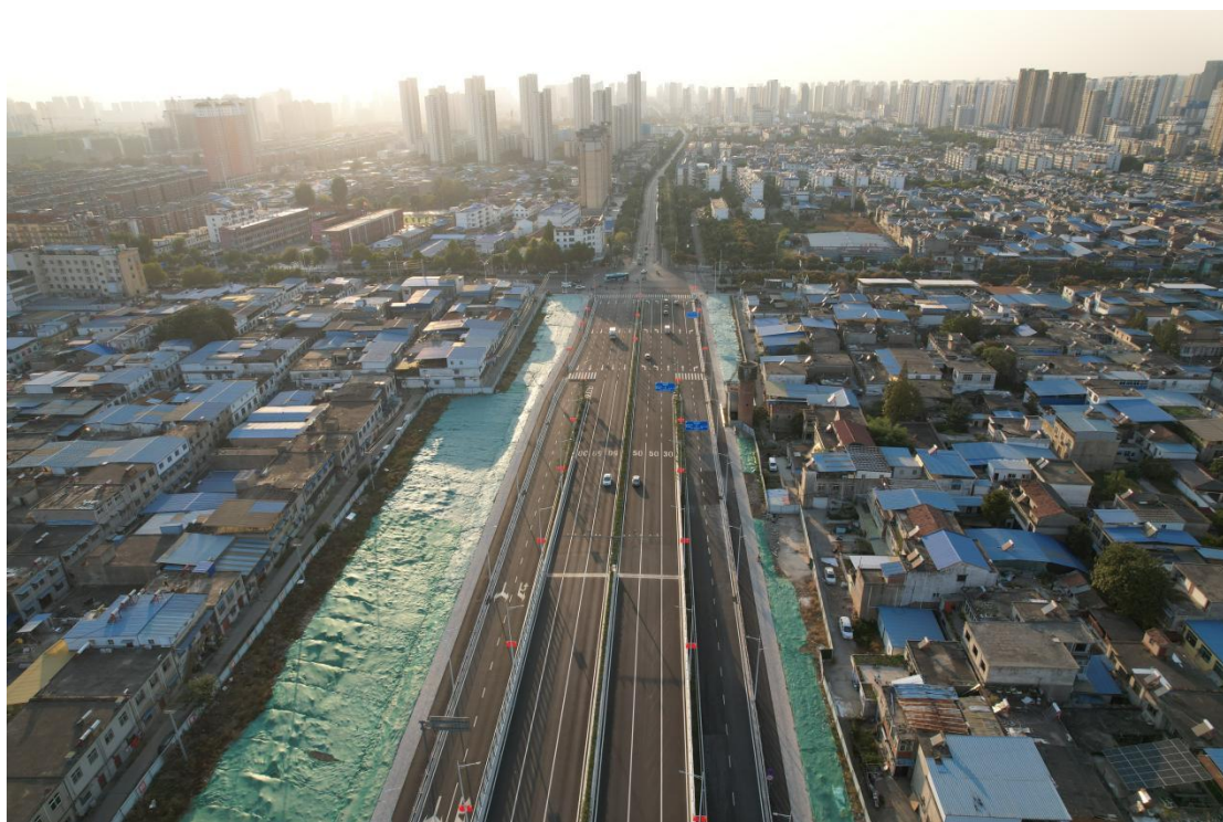
密目网临时覆盖措施
