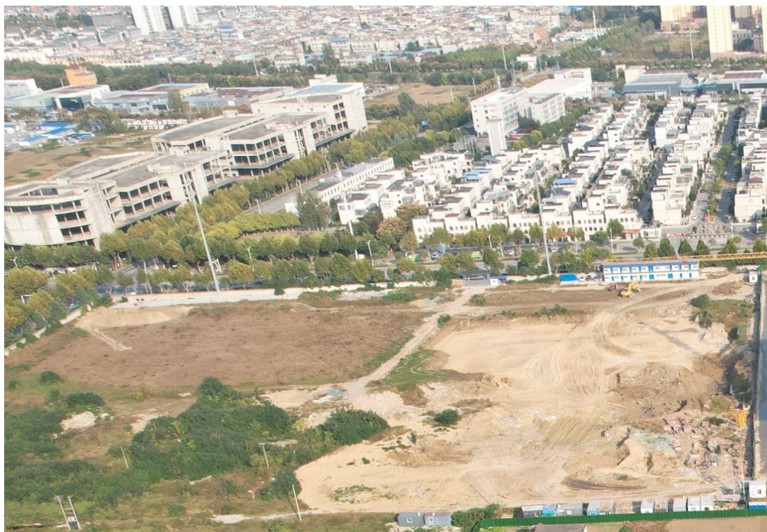
在建项目裸露地表情况
