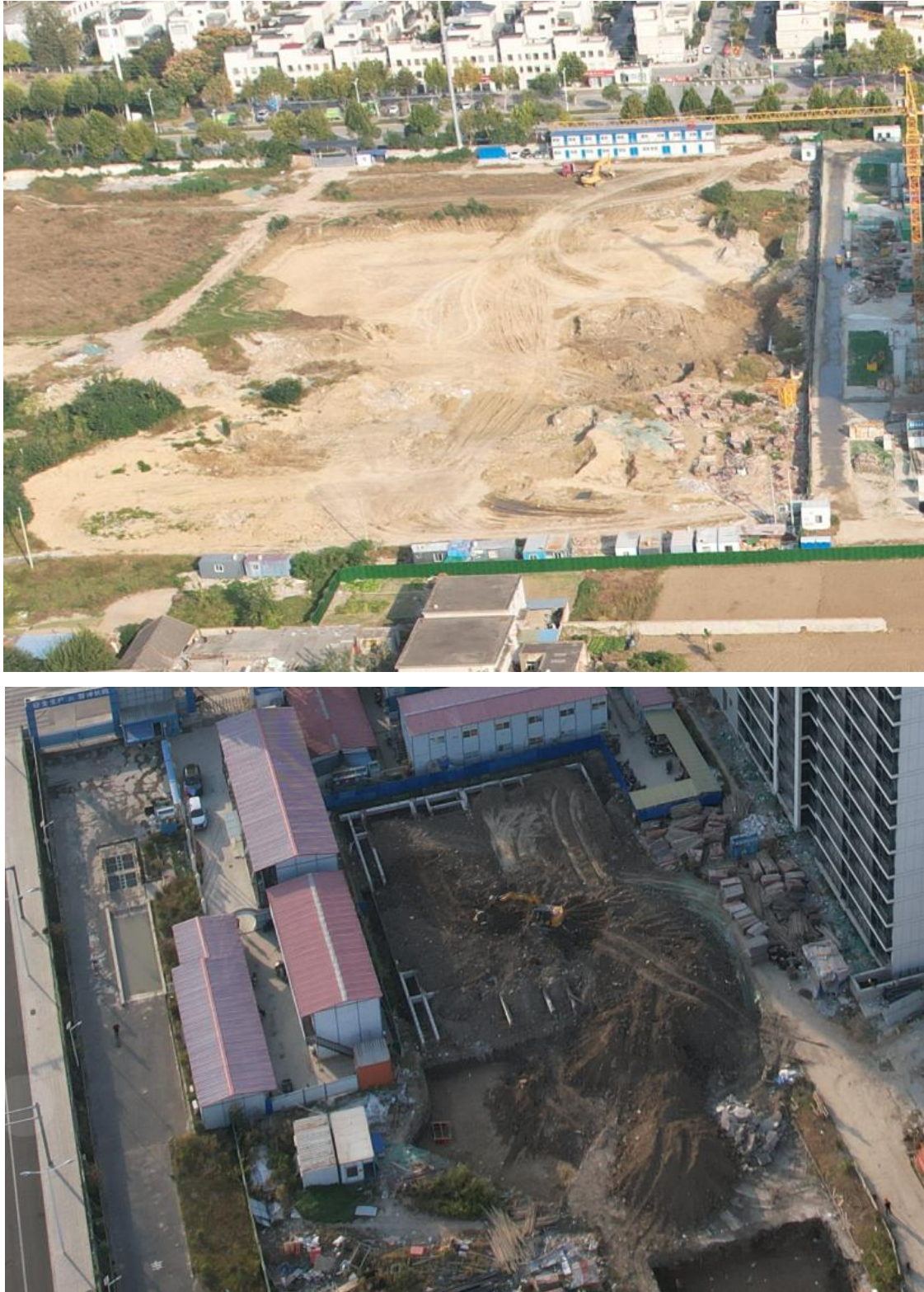
图 3-3 开发区内临时堆土无人机航拍监测
